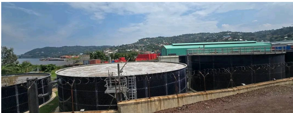
Figure 7 : Usine de traitement des déchets de la Bralima
