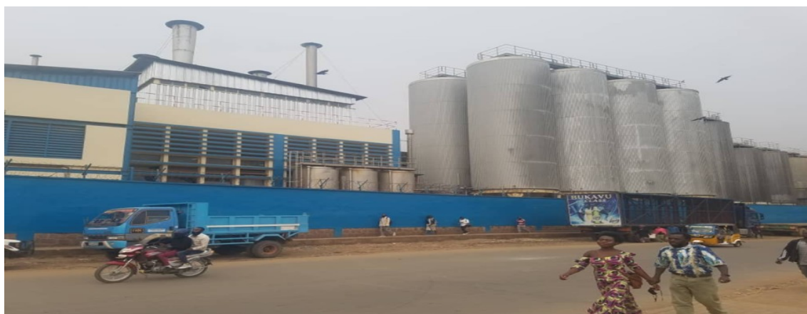
Figure 3A : Usine de la Bralima Brasserie BUKAVU
