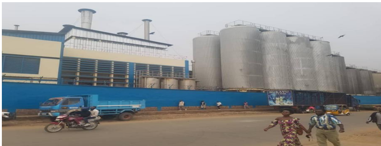
Figure 3A : Usine de la Bralima Brasserie BUKAVU
