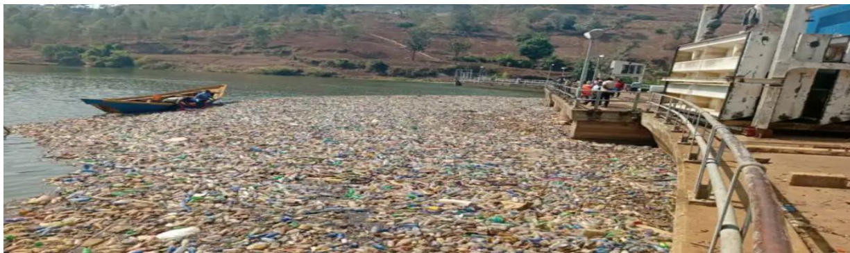
Figure 4 : le barrage hydroélectrique de Ruzizi 1.
